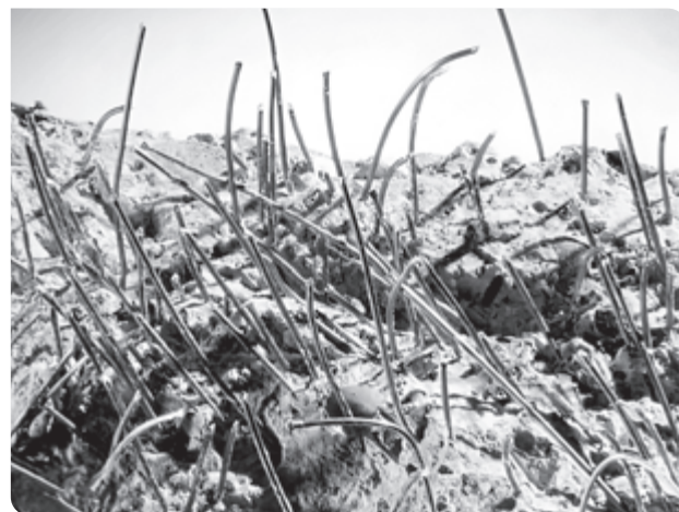
شکل ۱-۱۰ سطح شکست نمونه‌ای از بتن مسلح‌شده با الیاف فولادی
