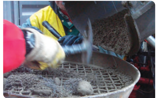
شکل ۲-۲- توده‌شدگی الیاف در محل ورودی پمپ.
