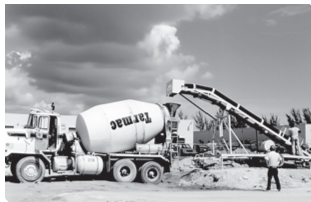
شکل ۲-۱- تصویری از اجرای بتن الیافی فولادی
