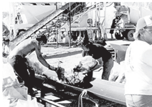
شکل ۱-۲۲- اضافه کردن الیاف فولادی از طریق نوار نقاله
